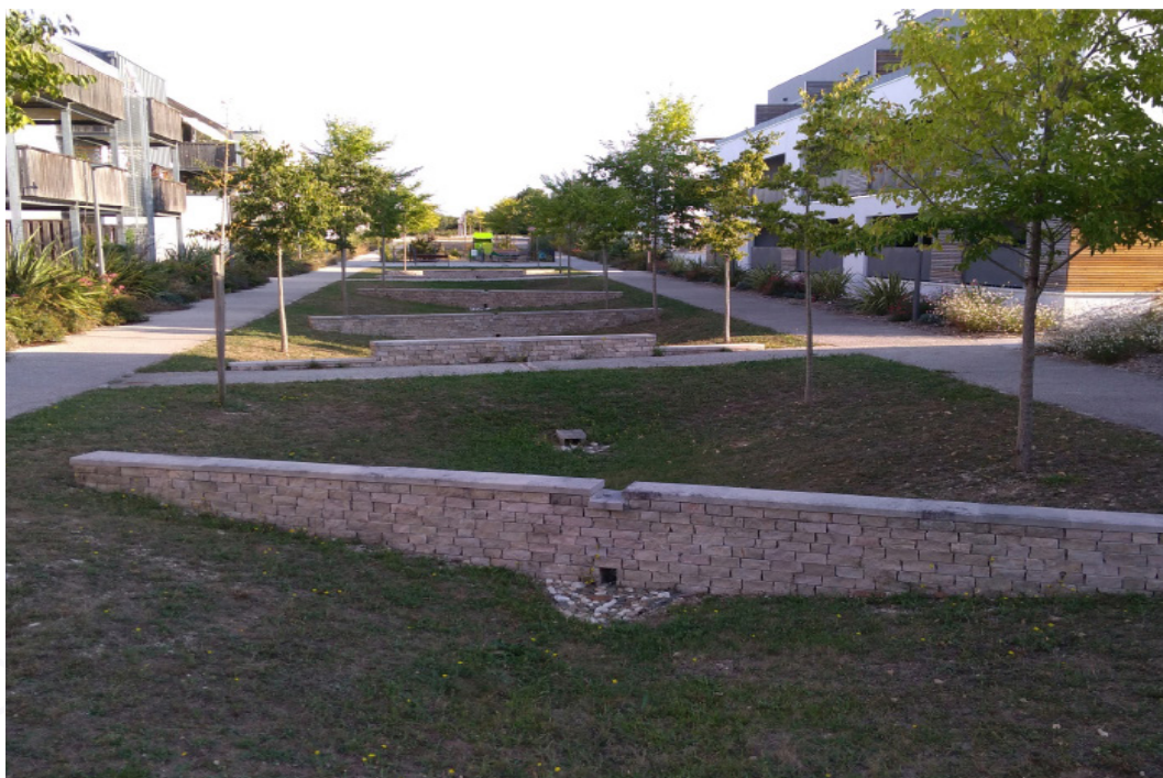
Lotissement avec gestion des eaux pluviales intégrée aux espaces verts à Périgny
